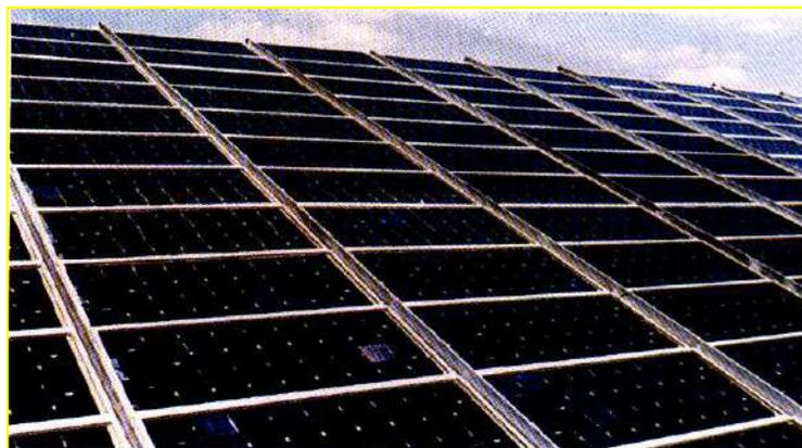
Pour augmenter la puissance, on groupe les modules PV en série/parallèle dans des champs PV
